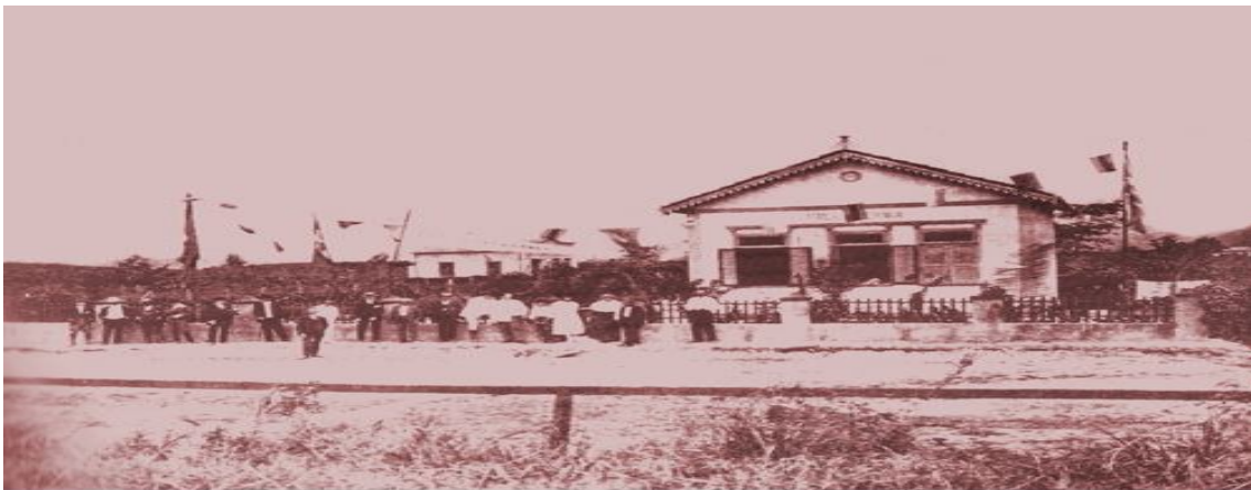
Villa Emma, primeira casa de alvenaria construída pelo Coronel Júlio de Abreu, em 1914, após o loteamento da Fazenda São Matheus.
