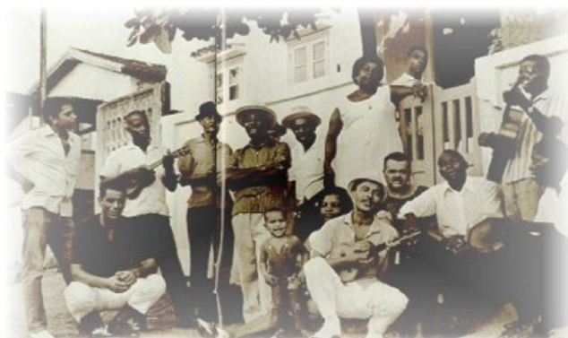
Foto 07: foto após gravação do primeiro disco
